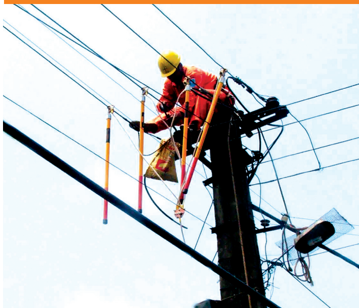
Việc theo dõi sửa chữa công trình điện cũng được EVN ứng dụng phần mềm “cây nhà lá vườn”
