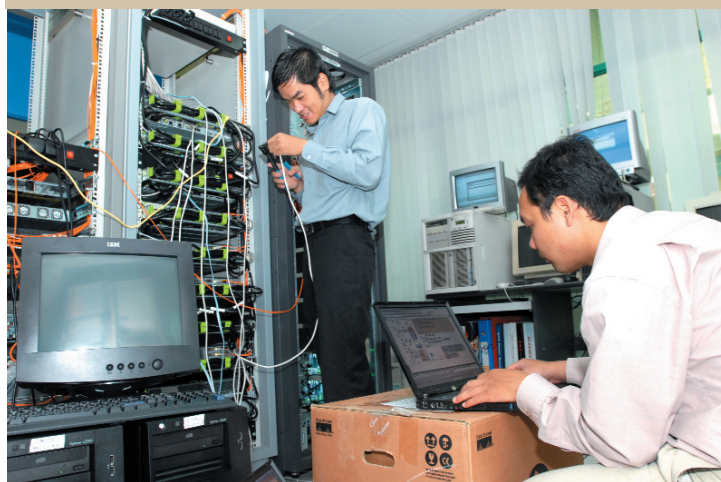
Triển khai lắp đặt mạng truyền số liệu tại các cơ quan Chính phủ.
